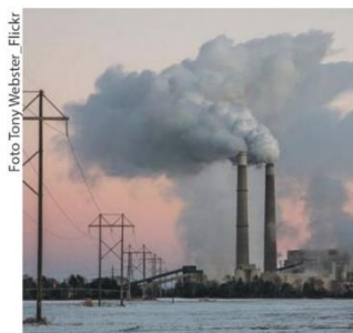
Geração de energia
