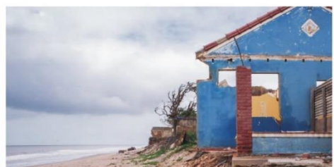
Casas destruídas pelo aumento do nível do mar Atafona, RJ - 2021
